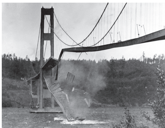
160-расм. Америкадаги Такома кўпригининг бузилиши: 1940 йил
