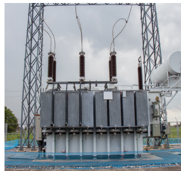
253-расм. Станция олдидаги куч трансформатори.
