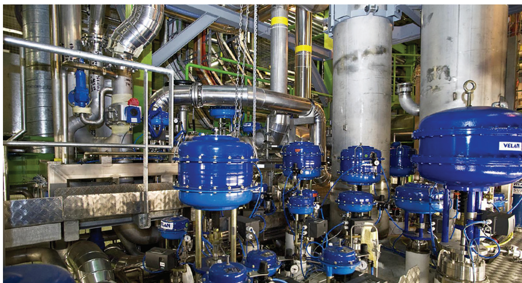
187-расм. ЎАС криоген тизимининг суюқ гелий учун керак 271,25°С температурани ушлаб турадиган қисм
